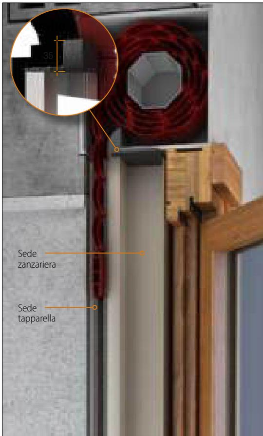
Al fine di integrare con facilità il sistema zanzariera con il sistema tapparella sono state create due guide specifiche dotate di una sezione, completa di spazzolini e di apposito invito per lo scorrimento della tapparella (profilo 14x55 mm) e una seconda sezione per l'inserimento dei sistemi zanzariera incasso da 50 mm. Un sistema integrato che arricchisce la casa con una finitura sicuramente di alto pregio.
